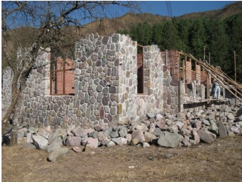
NW angle of new chapel at Rio Lozano angulo Noroeste de la capilla nueva en Rio Lozano
