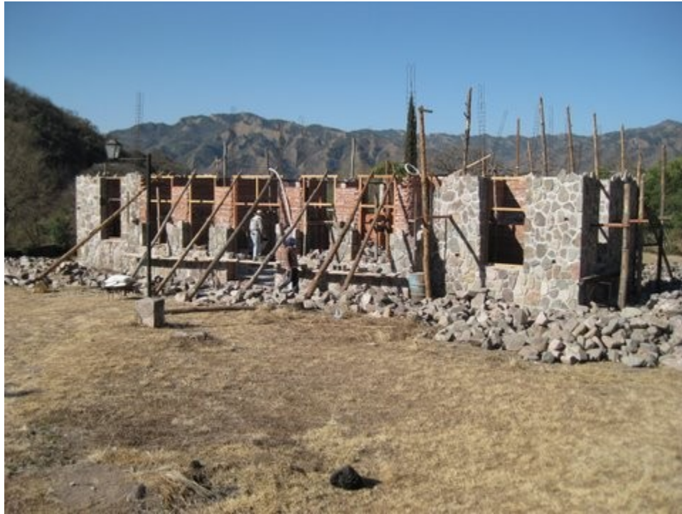
Here's a pic of the front of the chapel at camp Rio Lozano. Aqui tienes una foto del frente de la capilla nueva en Rio Lozano
